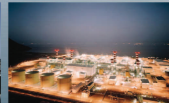
Fujairah, UAE [660MW+ 100MIGD]
